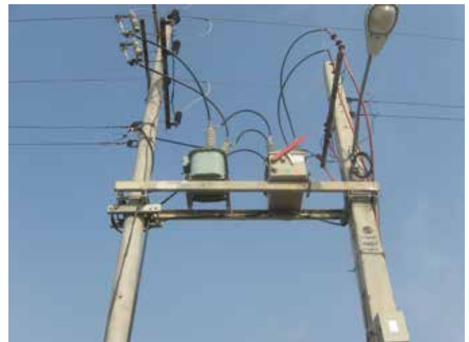
شکل (۱) نمونه ای از M.O.F نصب شده در شبکه توزیع برق مازندران
